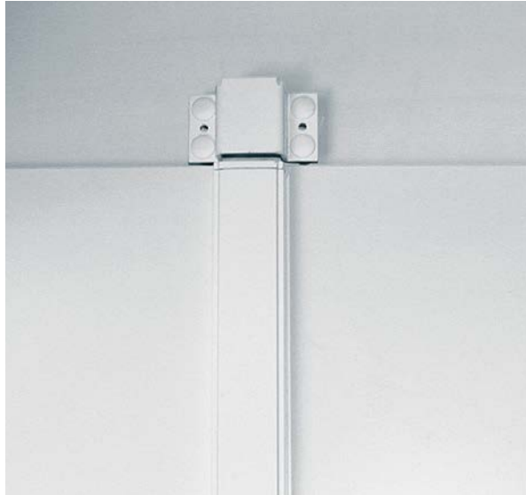
Abbildung 7: Stangenverschluss mit Verschlusspunkt oben
