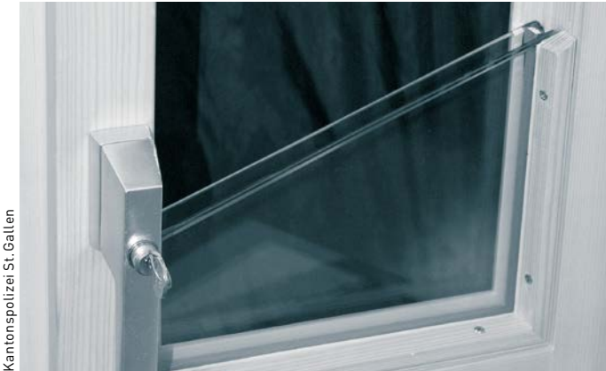
Abbildung 13: Verbundsicherheitsglas (VSG) P4A für RC 2 nach EN 356 (Sonderverglasungen)
